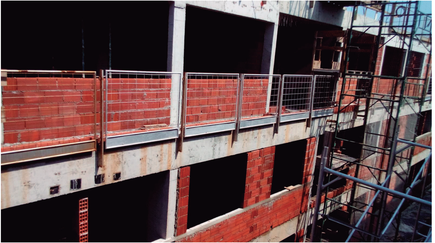
Construtora Tecto - Empreendimento Villagio Residence - Barra da tijuca/Rj
